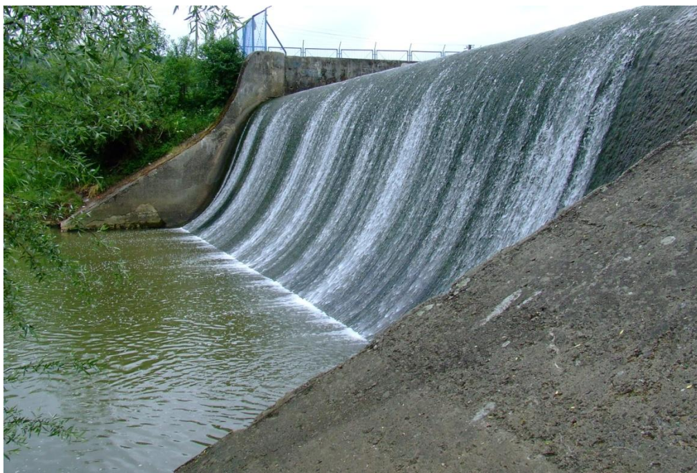
Fot. 1. Betonowy jaz na Uszwicy z 1913 roku – stan obecny (fot. Mariusz Osmęda)
